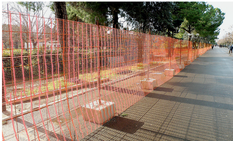
LAVORI IN CORSO La villa comunale recintata, un cantiere che mira alla riqualificazione [foto Calvaresi]
